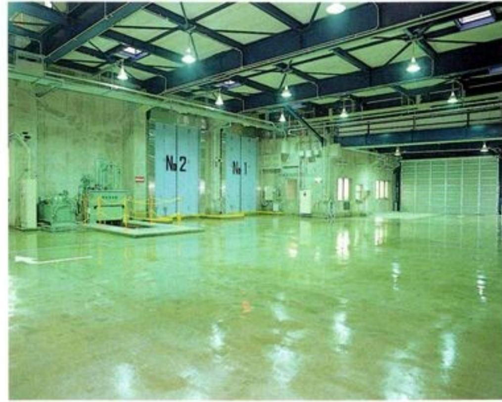
1 プラットホーム 計量されたごみが、プラットフォームのごみ投入扉からごみピットに投入されます。
