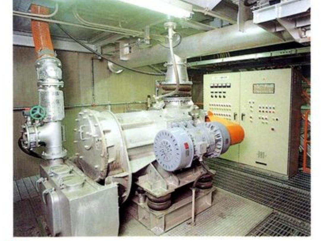
6 灰固形化装置 ろ過集じん器からのダストをセメントと混合し、固めます。
