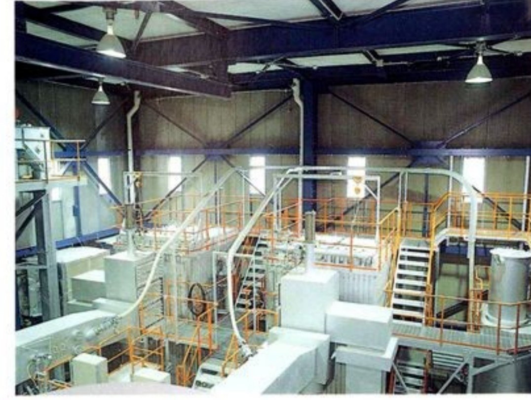
5 ろ過集じん器 焼却炉から出る排ガスに含まれた微細なばいじんを取り除き、きれいなガスにします。
