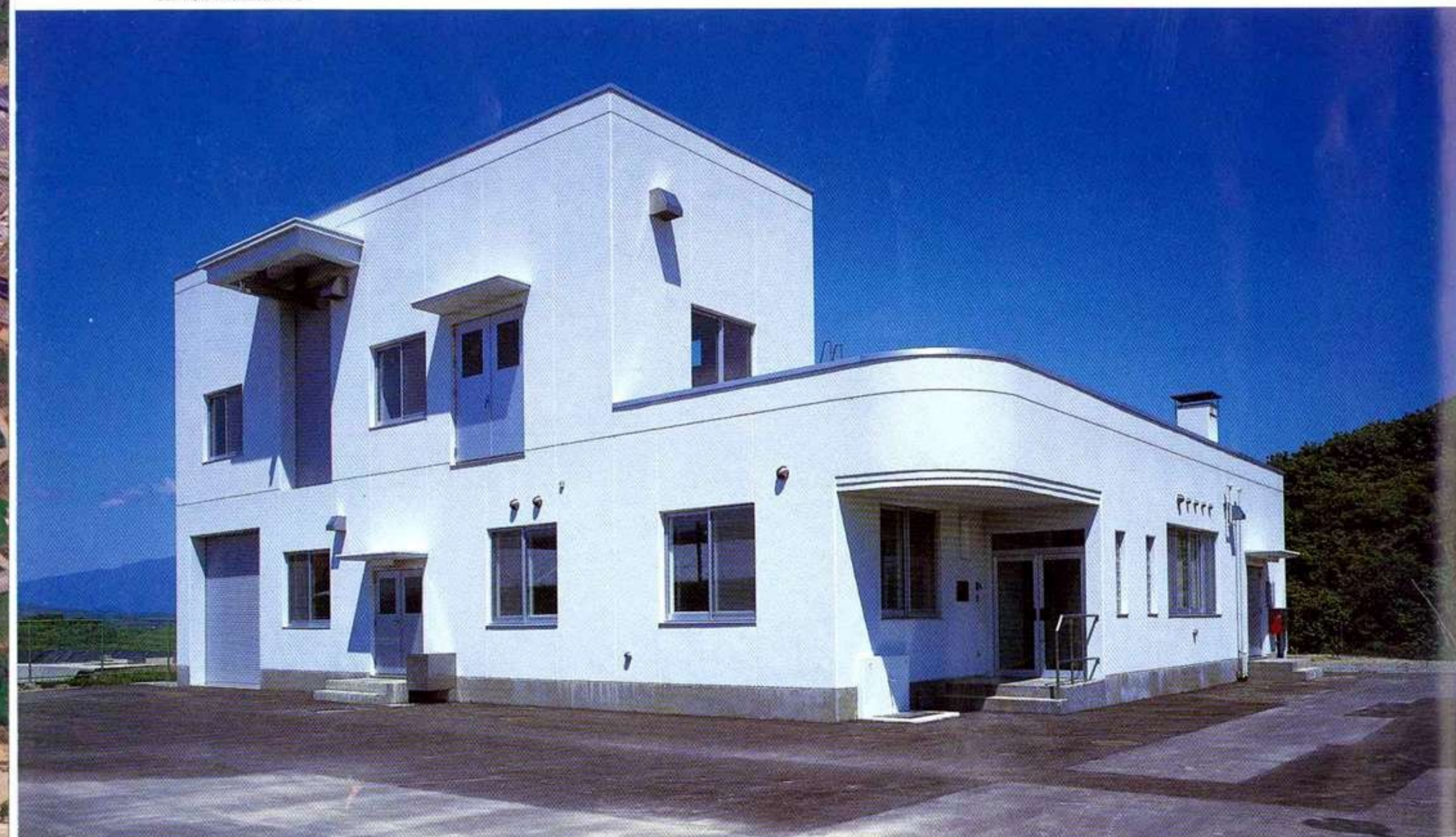
浸出水処理施設全景
